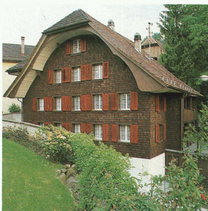
Fassaden-Renovation unter denkmalpflegerischer Beratung in Werthenstein. Qualität Nr. 1.
