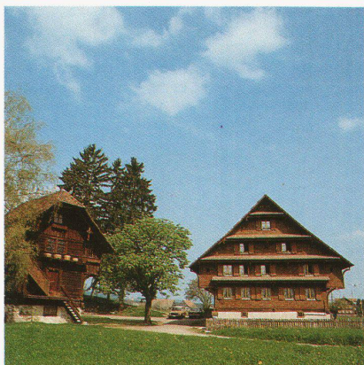
Fassaden-Renovation des alten Bauernhauses, Neudorf. Qualität Nr. 1, oberflächenveredelt.
