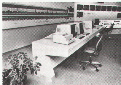
Wand- und Pult-Abdeckungen aus KELLCO in der Überwachungszentrale Airolo.
