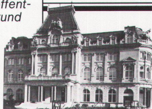
Bankgebäude in St. Gallen, SG. Altbau renoviert mit Holz/Aluminium-Fenstern.
