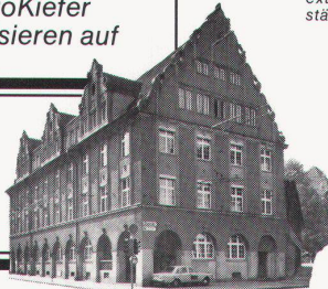
Verwaltungsgebäude in Winterthur, ZH. Altbau renoviert mit Kunststoff-Fenstern und Isolierverglasung.
