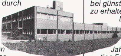
Industriebau in Liestal, BL. Neubau mit Kunststoff-Fenstern.
