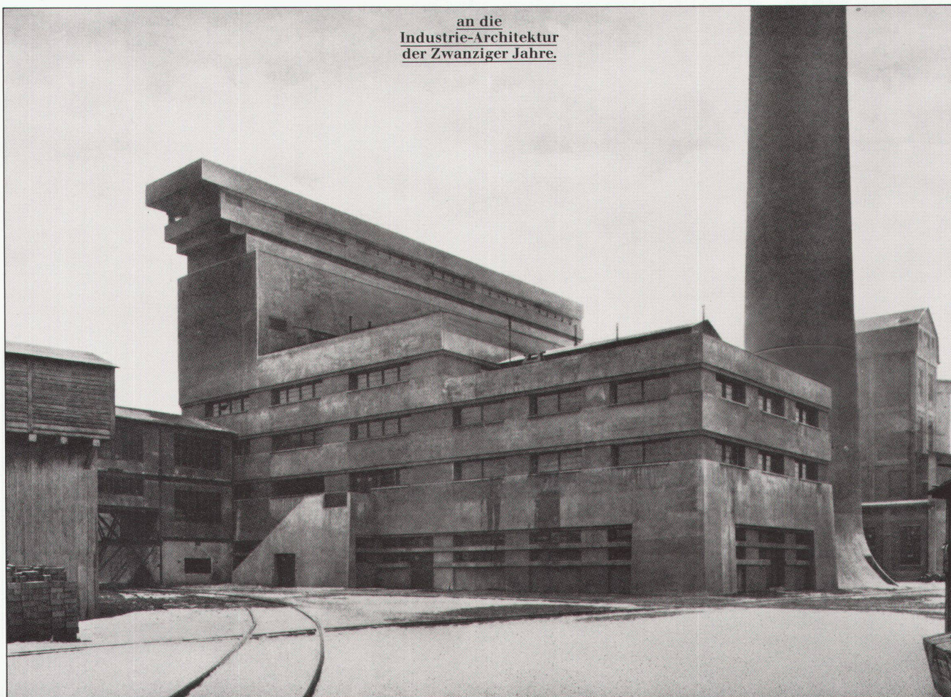
Kesselhaus des Werkes Königsberg i.Pr. Architekt: Edmund Meurin, Berlin
