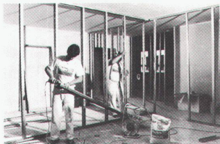
Montage der Metallständer-Unterkonstruktion.
