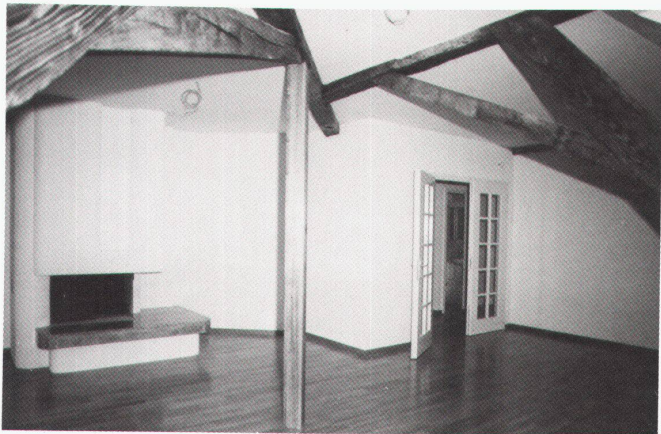
Ein mit Knauf-Paneelelementen neu ausgebauten Dachgeschoss bietet eine zusätzliche Wohneinheit.
