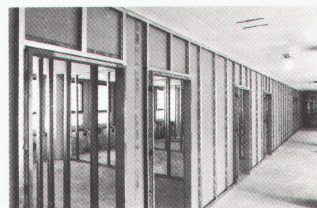
Einseitig beplankte Rigips-Leichtbauwände mit bereits eingebauten Türzargen.
