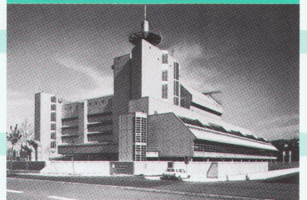
Theo Hotz Fernmeldebetriebszentrum Zürich
