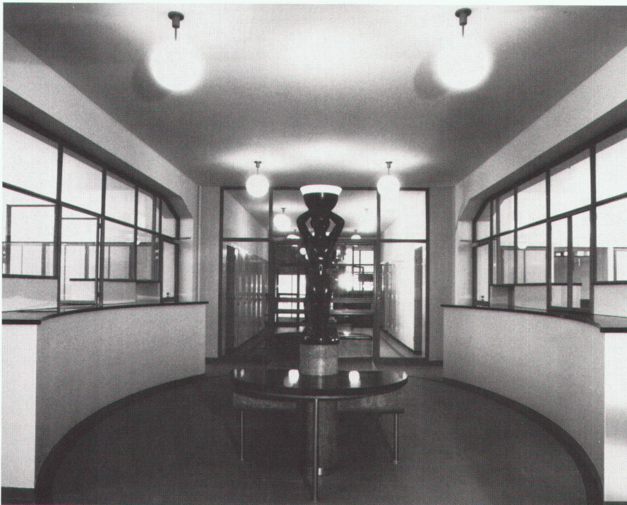
19 20 Schalterhalle im 1. Obergeschoss, Axonometrie und Ansicht / Hall des guichets au 1er étage, axonométrie et façade / Ticket hall on the 1st floor, axonometry and view
