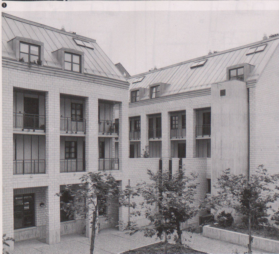
1 Ansicht von Westen, Strassenseite
