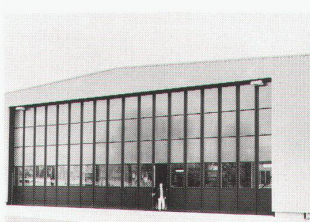
Hangartor 21×7,5 m, Limes AG, Kloten
