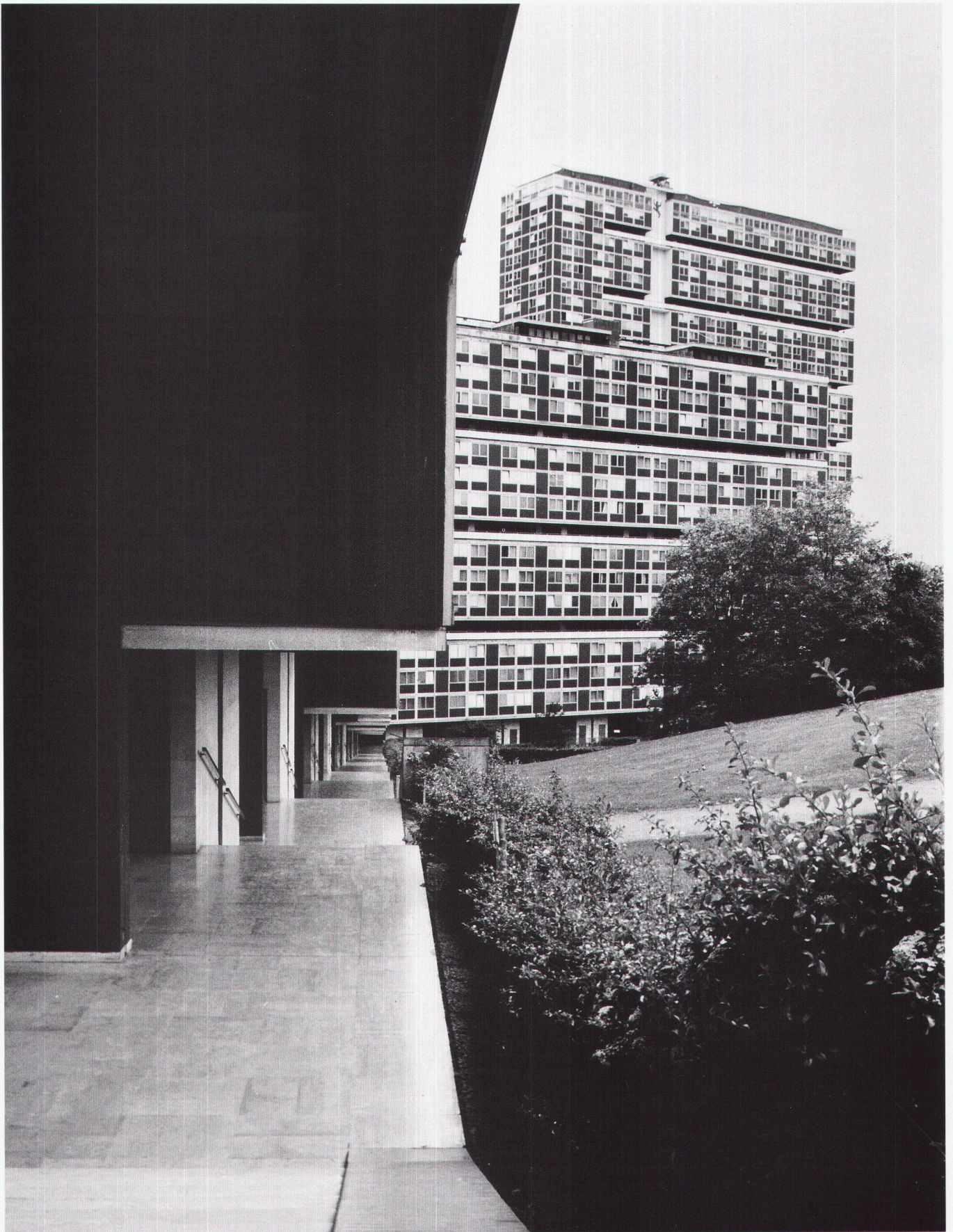
① Werk, Bauen+Wohnen 7/8/1989
