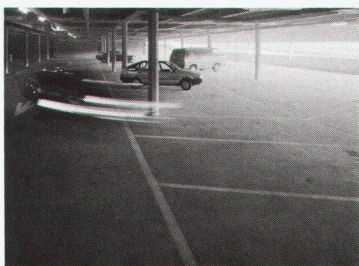
Parkdeck Glattzentrum, Wallisellen
