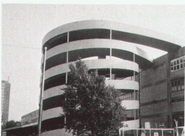
Rampe Parkhaus Migros Herdern
