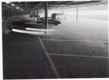
Parkdeck Glattzentrum, Wallisellen
