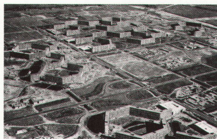
2 1 Vogelperspektive der Gesamtanlage / L'ensemble vu à vol d'oiseau / Bird's-eye view of the entire complex
