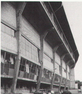
9 10 Fassadendetails / Détails de la façade / Details of elevation
