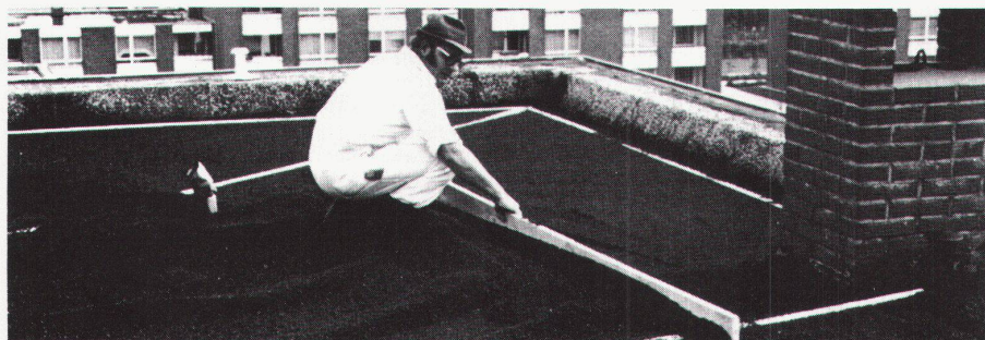
Das Material wird nach dem Anmischen mit Perlmix im gewünschten Gefälle über vorher ausgerichtete Lehren abgezogen. Nach dem Verdichten kann Thermoperl begangen werden.
