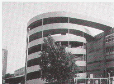
Rampe Parkhaus Migros Herdern
