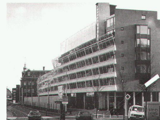
Wohngebäude Droogbak, Amsterdam, 1986–89, Architekt: Rudy Uytendaele
