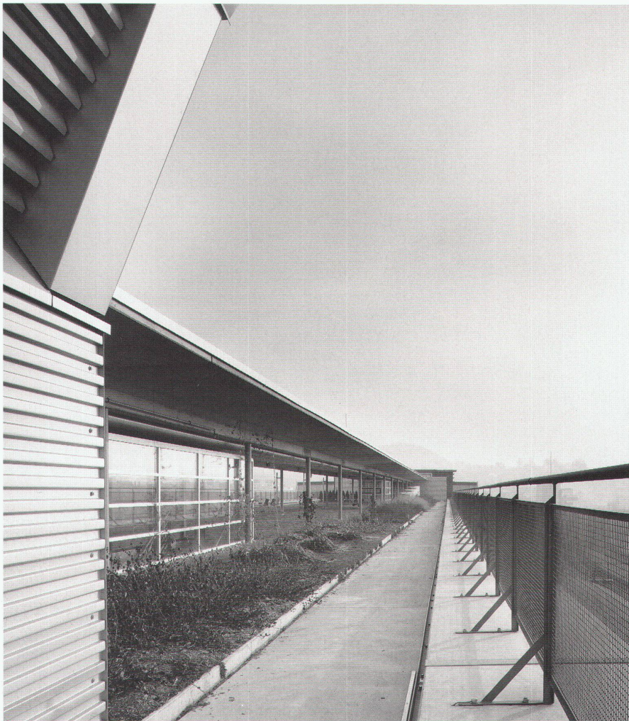
⊗ Dachterrasse / Toiture-terrasse / Roof terrace
