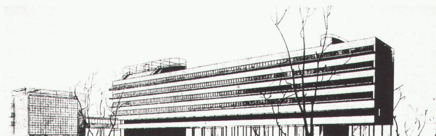
2 3 4 Aussengalerie und Wohnungsinneres, «Narkomfin», Moskau 1929, Moïse Guinzbourg (nach A. Kopp. Ville et révolution. Architecture et urbanisme soviétiques des années vingt , Paris 1967) / Coursive et intérieur d'appartement, «Narkomfin», Moscou, 1929, Moïse Guinzbourg (d'après A. Kopp) / Outside gallery and view of the interior, «Narkomfin», Moscow, 1929, Moïse Guinzbourg (after A. Kopp)
