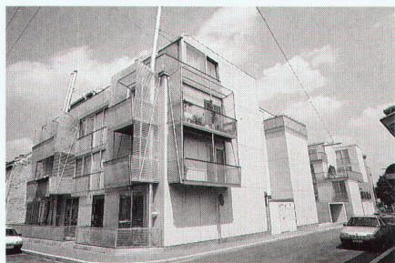
15 16 Querschnitt und Detail der mit Eternitplatten verkleideten Fassade / Coupe transversale et détail de la façade habillée de plaques en eternit / Cross-section and detail of the façade clad with eternit
