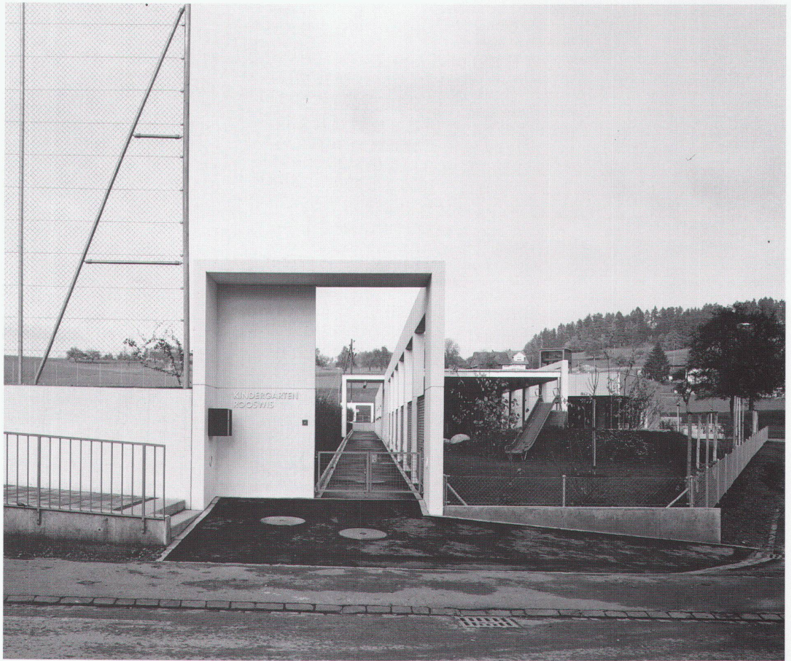
Zugangsbereich des Kindergartens
