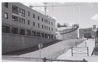
Evry, Zentrum mit Kathedrale von Mario Botta, im Bau Evry, centre avec cathédrale de Mario Botta, en construction Evry, town centre with cathedral by Mario Botta, under construction Foto: Max Bosshard, Luzern
