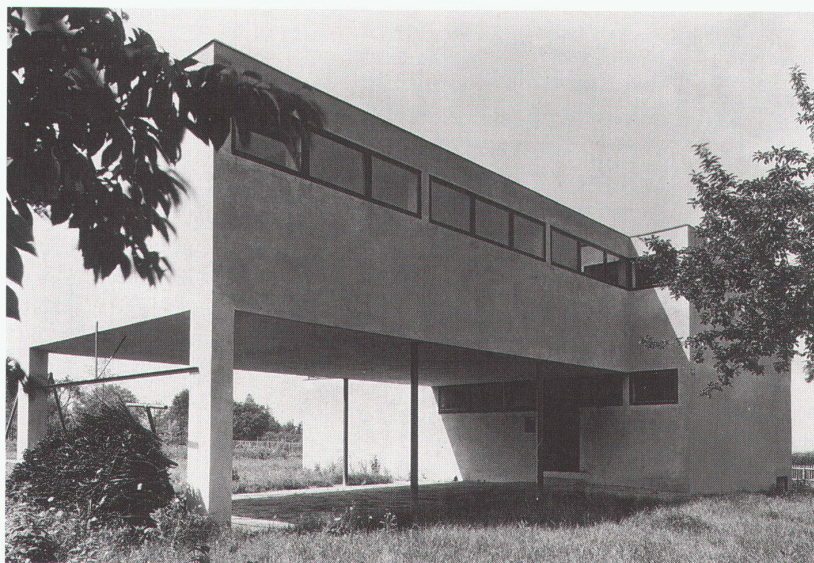
Haus Schaefer in Basel, 1928, von Hans Schmidt und Paul Artaria, vor und nach der Renovation (von Herzog & de Meuron, Basel), die insbesondere die Verglasung des ehemals offenen Erdgeschosses umfasste.
