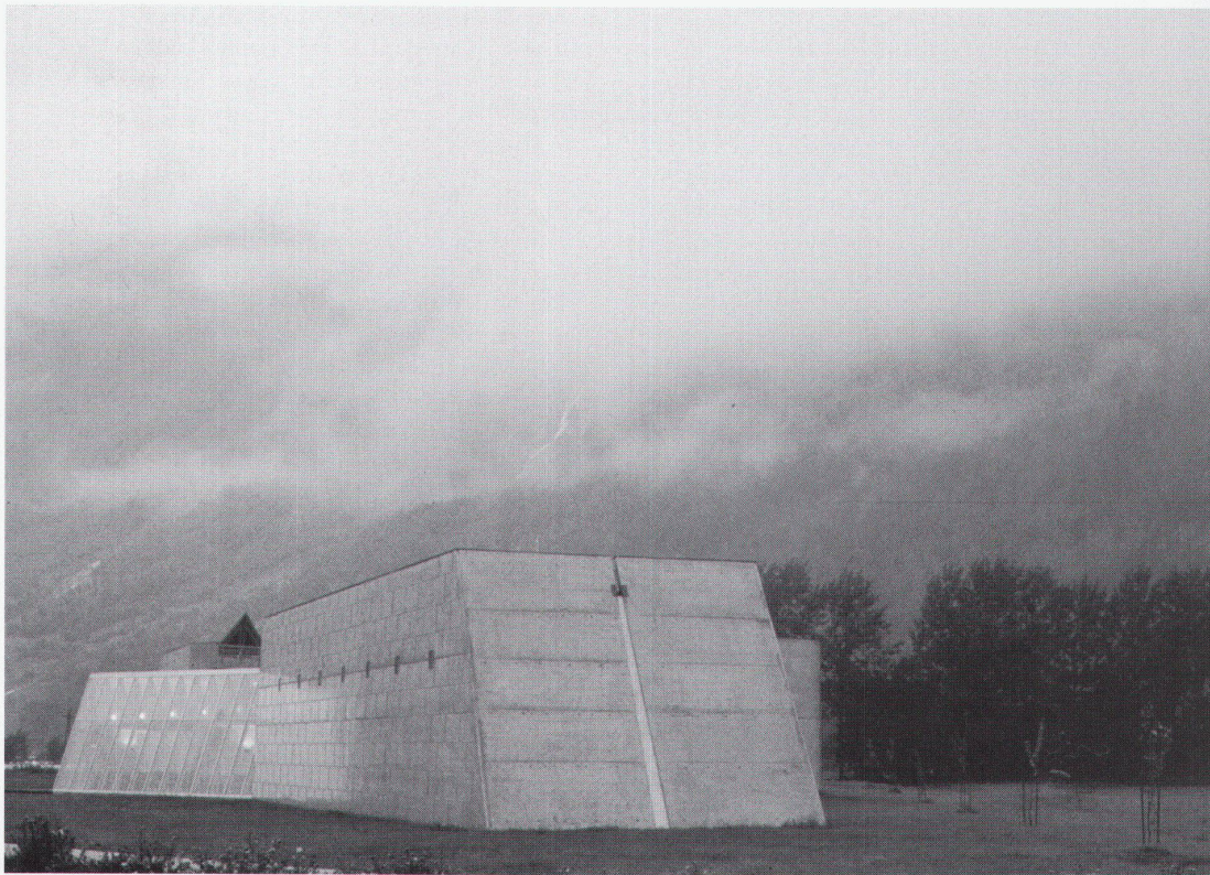
Ansicht von Osten Vue de l'est View from the east
