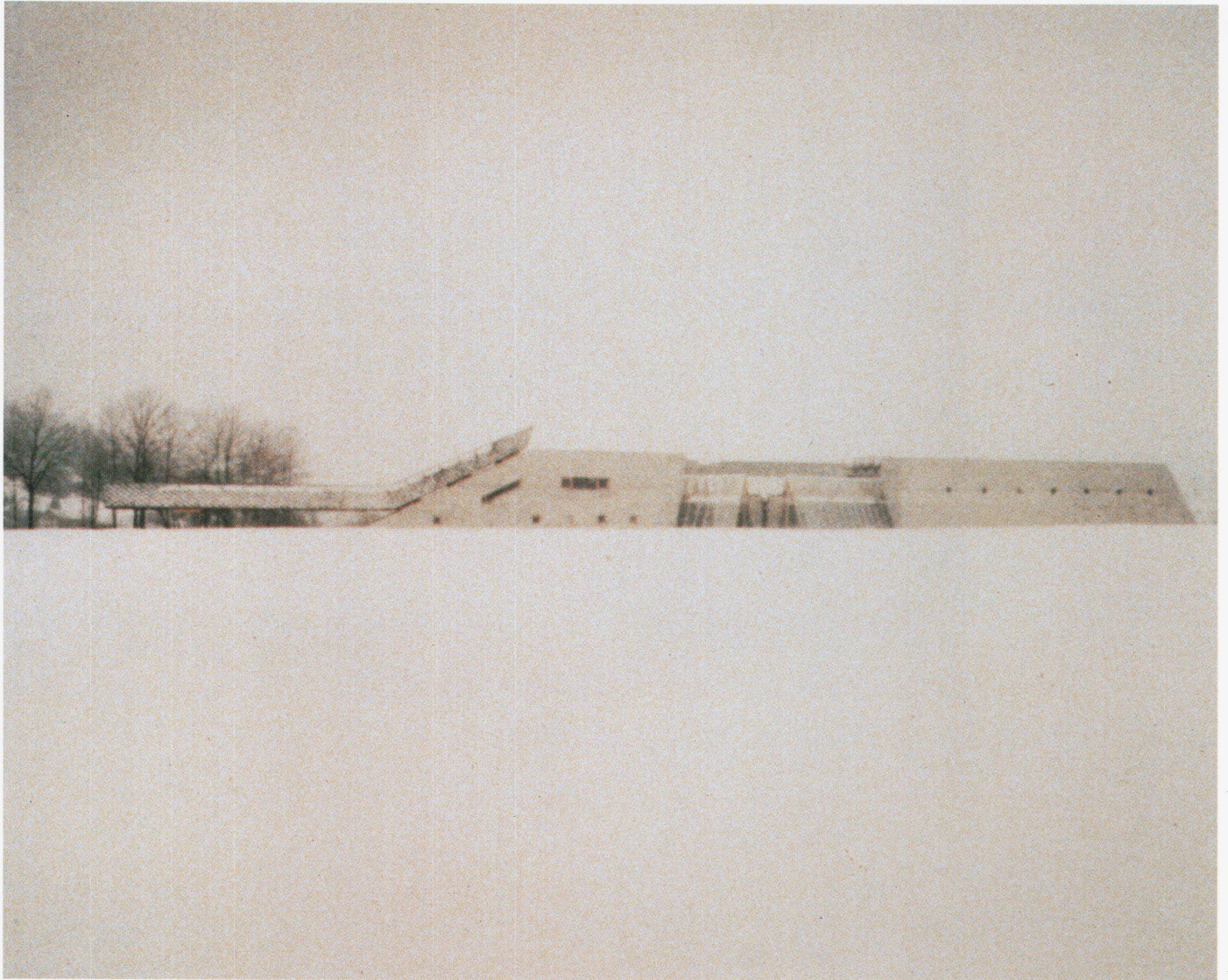
Ansicht von Süden Vue du sud View from the south
