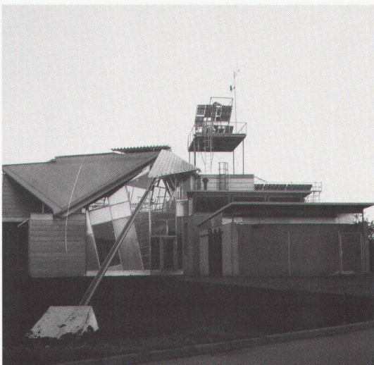
Hysolar Forschungs- und Institutionsgebäude der Universität Stuttgart, 1987, Ansicht von Norden
