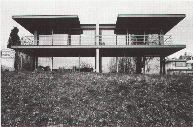
Überbauung in Feldmeilen, 10 Doppelhäuser, 1991
