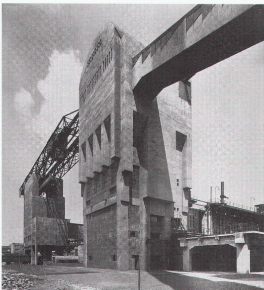
Adolf Meyer: Gaswerk Ost, Kokerei, Frankfurt, 1926/27
