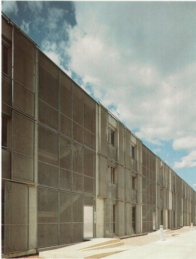
Westfassade: vorgehängte Schiebe- elemente aus Nylon ■ Façade ouest: éléments coulissants suspendus en nylon ■ West façade: sliding curtain wall elements made of nylon
