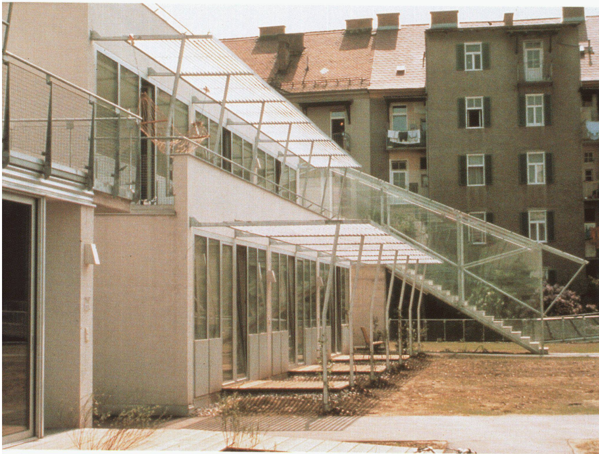
Die südliche Wohnzeile Le volume d'habitat sud The south row of houses Foto: Paul Ott
