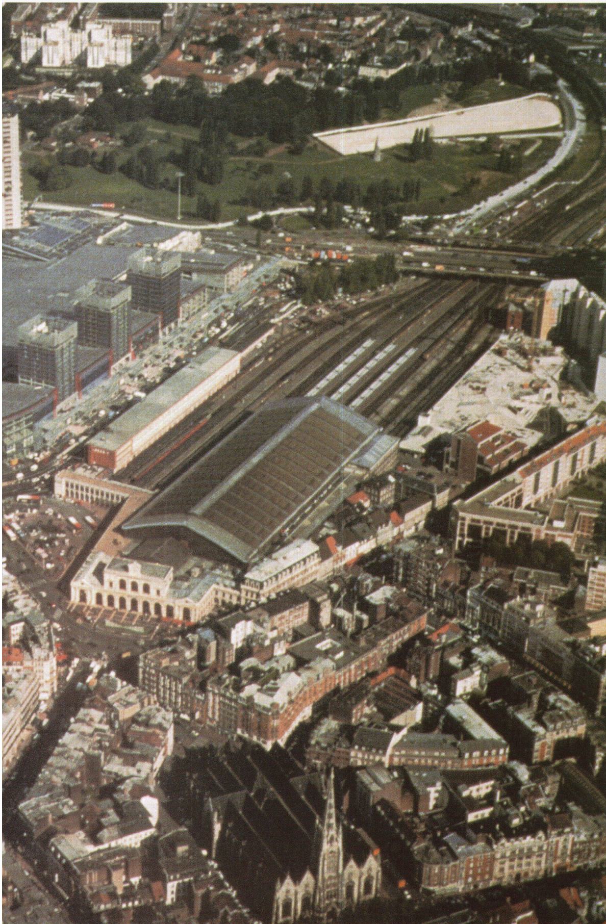
Gesamtanlage von Südwesten, Stand Ende September 1994 ■ L'ensemble vu du sud-ouest, état fin septembre 1994 ■ The whole complex from the southwest, end of September 1994
