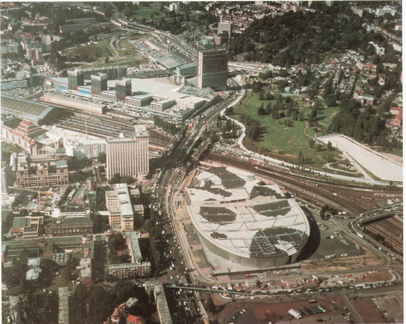
Gesamtanlage von Süden, Ende September 1994 ■ L'ensemble vu du sud, fin septembre 1994 ■ The whole complex from the south, end of September 1994
