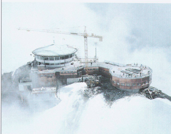
Schilthorn Gifelpfstation, Architekt A.F. Feuz
