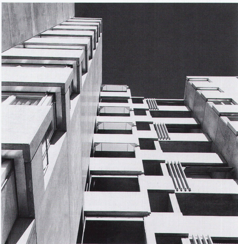
Fassadenansicht. Minimalisierte Elementstöße, schalungsglatte Betonoberfläche ■ Vue en façade. Minimum de joints entre éléments, béton coulé dans des coffrages lisses ■ View of the façade. Minimalised joints of the elements, smooth form- work concrete surface. Foto: F. Maurer, Zürich
