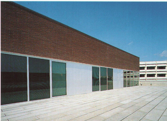
Dachterrasse ■ Toiture-terrasse ■ Roof terrace
