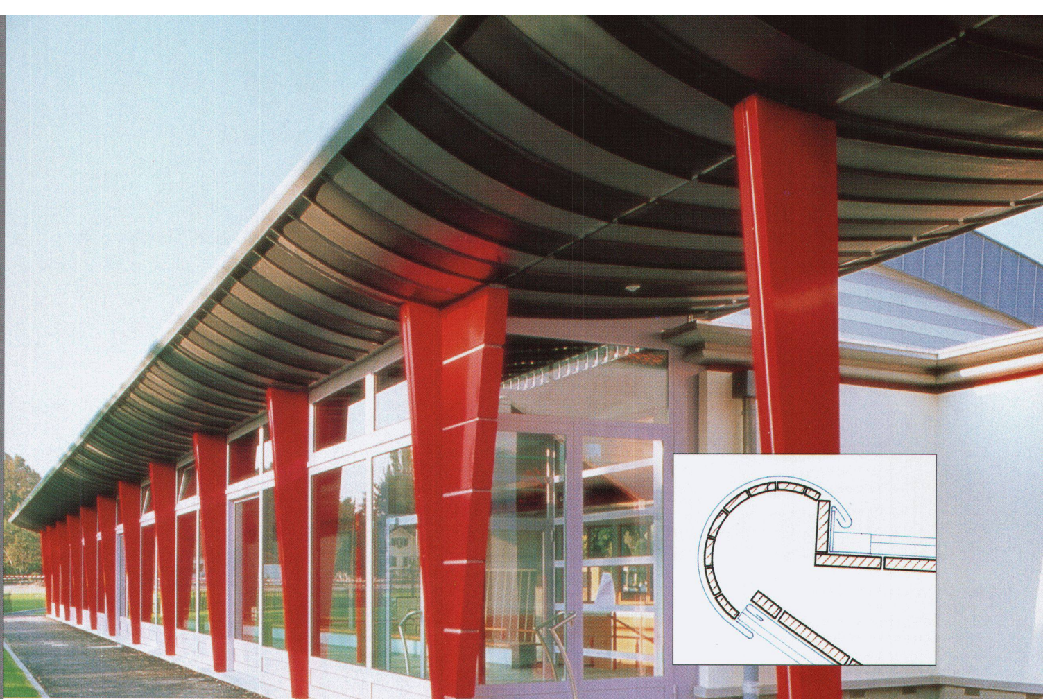
Salle de gymnastique, 1294 Genthod. Architekten: Redard-Barro-Haldinger, 1227 Carouge. Spengler: Cerutti Toiture SA, 1226 Thônex.
