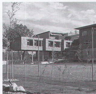
Ansicht von Nordosten Ansicht von Norden Foto: Hannes Schild, Wien
