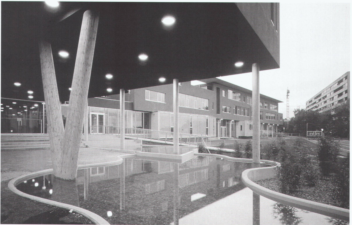
Quertrakt über dem Eingang, von Osten
