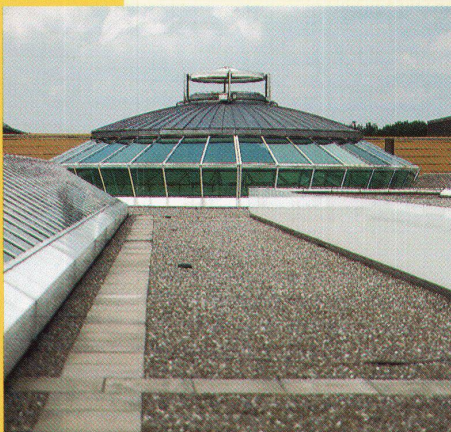
Umbau Einkaufszentrum Glatt. Mit Sarnafil T.
