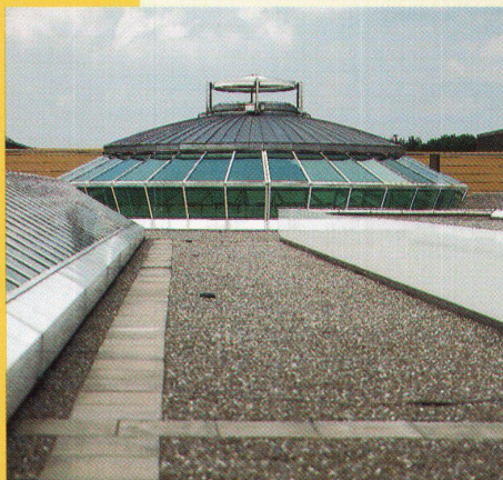
Umbau Einkaufszentrum Glatt. Mit Sarnafil T.
