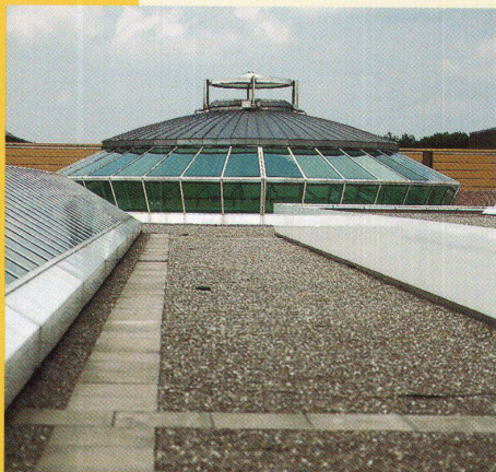
Umbau Einkaufszentrum Glatt. Mit Sarnafil T.
