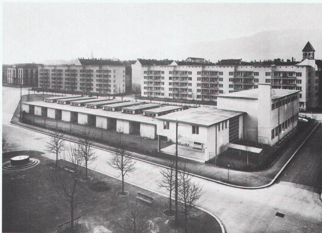
Mehrfamilienhäuser der ABZ und städtischer Kindergarten in Zürich-Wiedikon, 1931–1932
