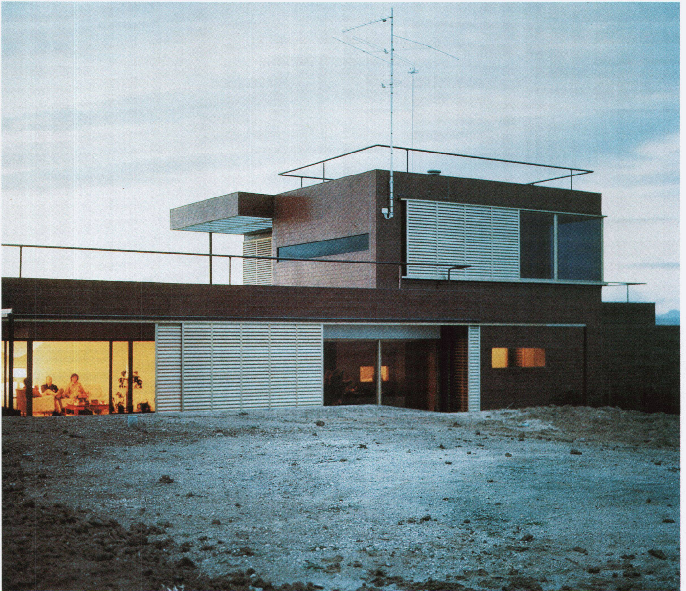
Ansicht von Südosten ■ Vue de sud-est ■ View from south-east
