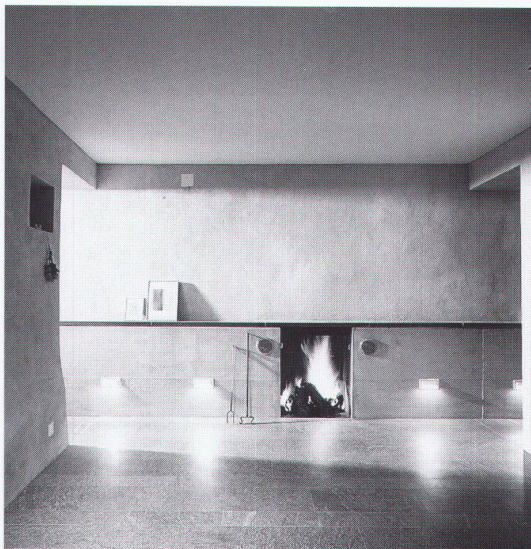
Vormauerung mit Kamin und Fußbodenbeleuchtung
