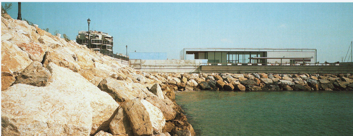
Aufgang zur Terrasse
