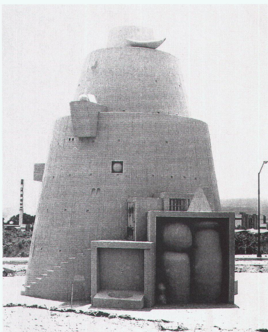
Baustelle von 1968 ▷ Chantier de 1968 ▷ Building site, 1968
