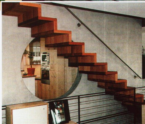
Die Firma Innenausbau Mäder AG hat eine Treppe entwickelt, die ohne abzustützen nur an die Wand befestigt wird.
