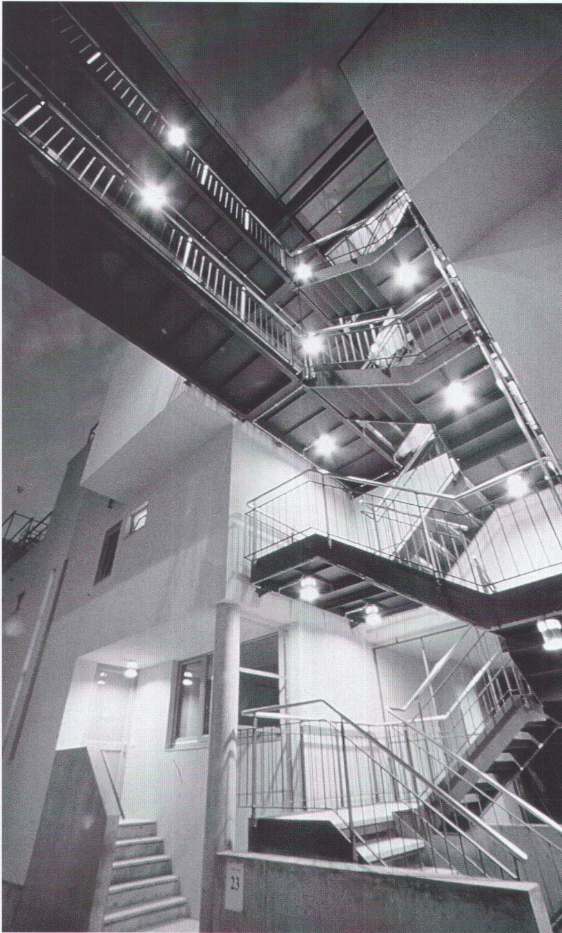
Treppenhaus in der «Terrasse»
