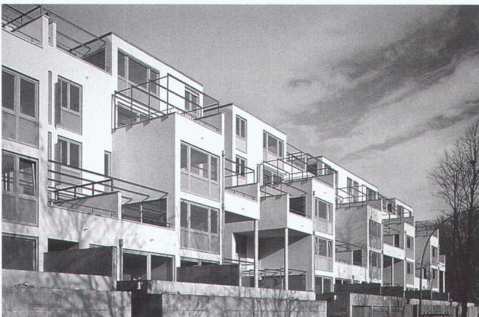
Die Fassade Turmweg
