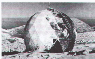
Abb. 2: Radarkuppel auf dem Mount Washington, 1954, 1350 kg. Aus: John McHale: R. Buckminster Fuller. Bd. 4: Architekten von heute. Ravensburg: Otto Maier, 1964, Abb. 71
