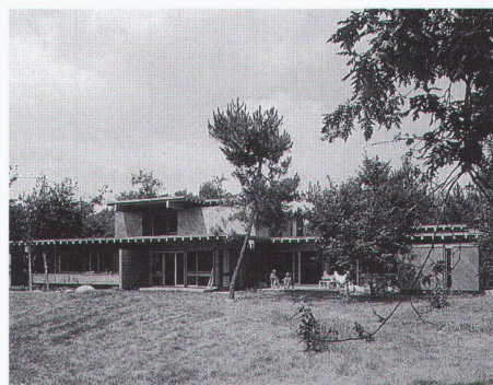
Haus Pierre Lajus, Mérignac, 1973–1976 Architekt: Pierre Lajus
