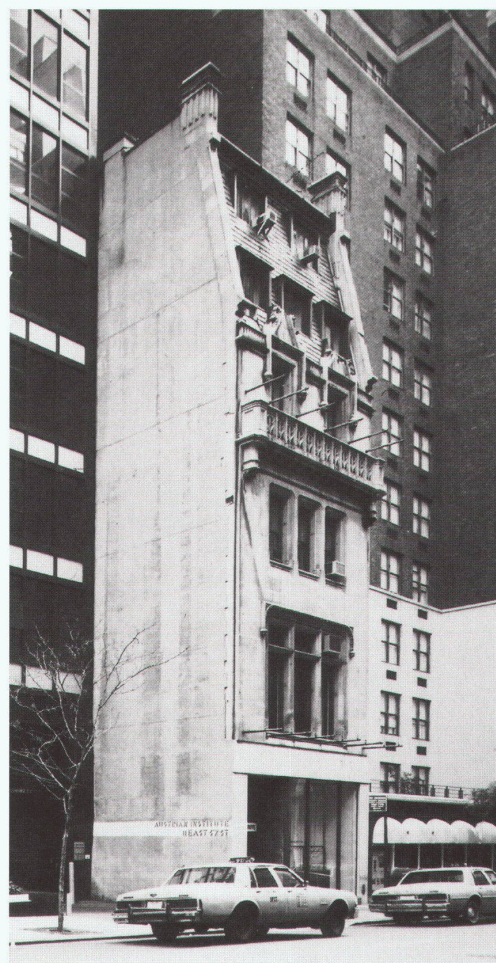
Das alte Kulturinstitut vor dem Abbruch.
