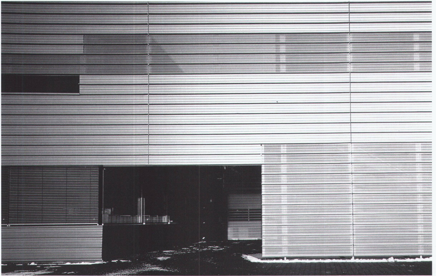
Eingang von Aussen und Innen
